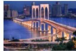
Ponte de Sai Van
